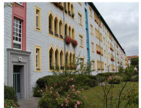
Vorderansicht Wohnanlage 1 Bismarckstr.
